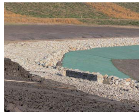
Obr. 5: Pohled na břehovou linií s rozrážečem, kamennou lavicí a protierozním opatřením pod rozrážečem.
