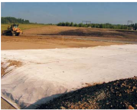
Obr. 7: Výstavba roznášecího polštáře s pomocí vysokopevnostního geosyntetického kompozitu
