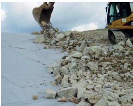
Obr. 8: Opevnění svahů hrází lomovým kamenem na stranách od jezera
