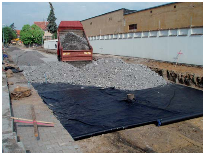
Obr. 3: „Tkaná geotextilie“ - výrobek musí být správně instalován podle doporučení výrobce a jeho návrhu k instalaci
