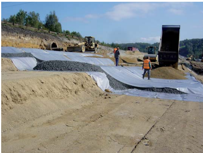
Obr. 2: „Netkaná geotextilie“ - výrobek musí být správně instalován podle doporučení výrobce a jeho návrhu k instalaci
